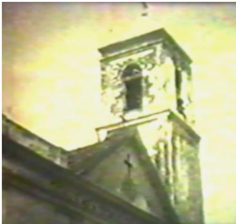
Imagen de la torre de la iglesia de San Javier antes de la colocación del reloj (1916)
